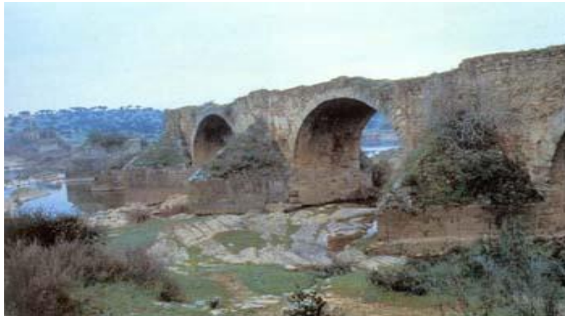
Imagen 11 Puente Ayuda (frontera portuguesa).
