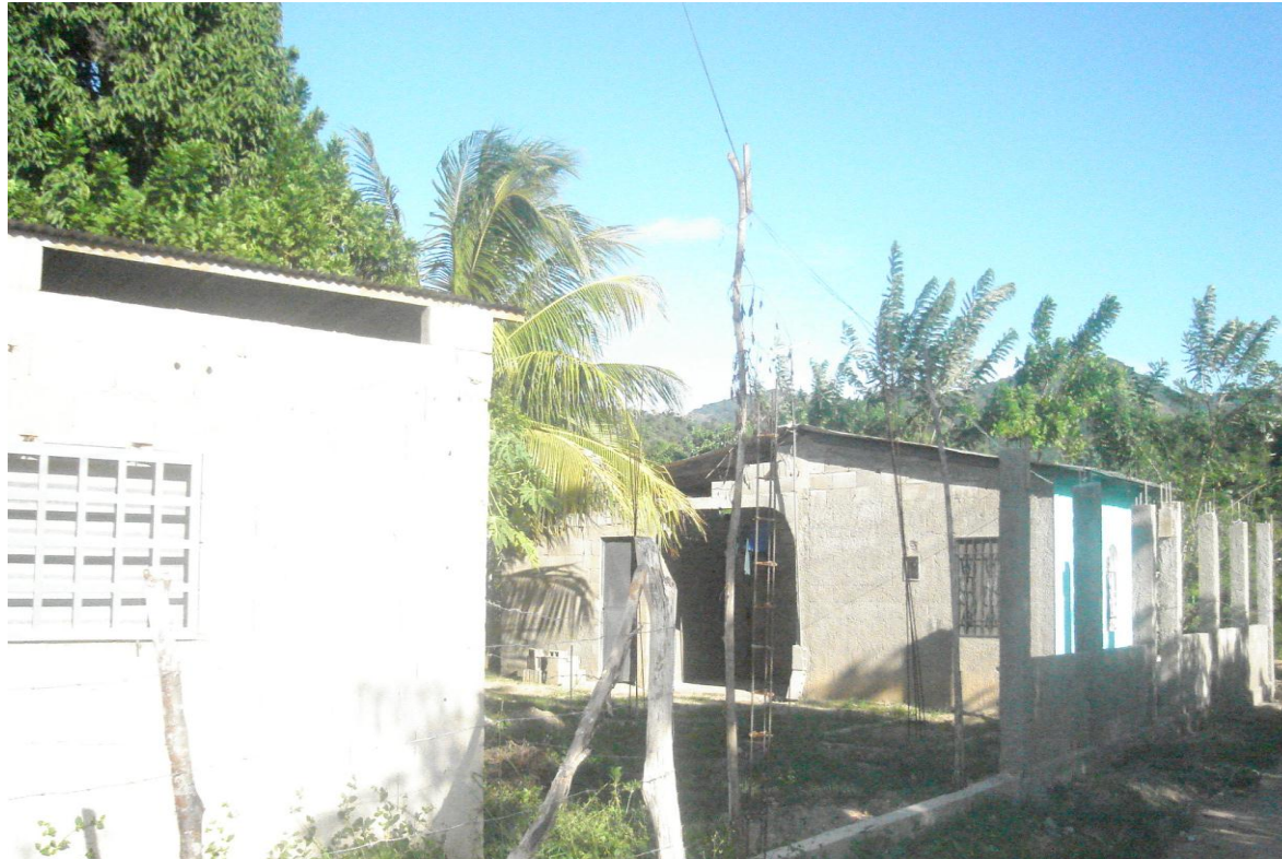
Postes inadecuados (rama de árbol) utilizado para la conexión eléctrica de las viviendas de la Comunidad de Andrés Bello.
