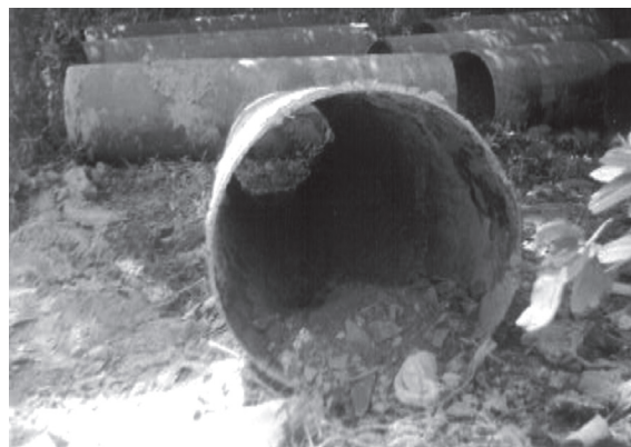
Fig. 2. Vista transversal de colector seccionado estación de bombeo balsa toma-tanque de agua cruda en planta de tratamiento “Angostura” ubicada en Ciudad Bolívar.
