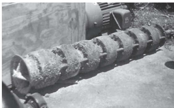
Fig. 10. Vista parcial de un cuerpo de cabezales de bomba incrustada en forma de cúmulos en la planta de tratamiento "Angostura" ubicada en Ciudad Bolívar.
