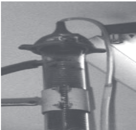
Fig. 1. Línea de succión del sistema de muestreo activo para la recolección de emisiones en la torre de destilación por platos.
